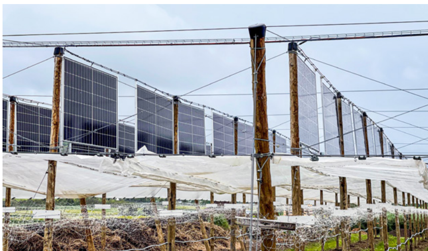
Abb. 7: Bifaziale PV-Module
