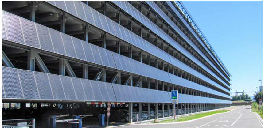
Abb. 26: Solarstromanlage, die in das architektonische Konzept des Parkhauses integriert wurde
