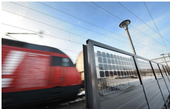
Bifaciale Solaranlage entlang der Bahnlinie - Sonnensegel - Veloville
