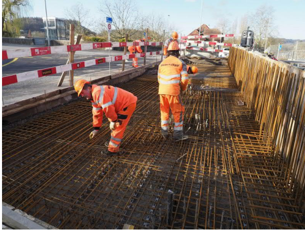
Provisorien werden erstellt, auf dem Bild die Betonplatte stadtseitig
