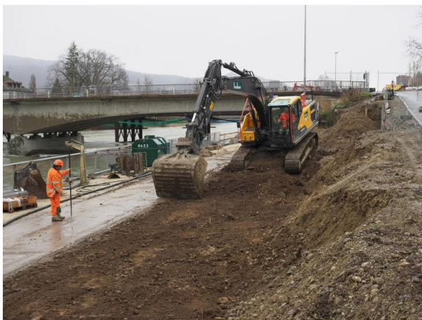
Baugrubenaushub für die Erstellung der Baugrubensicherung
