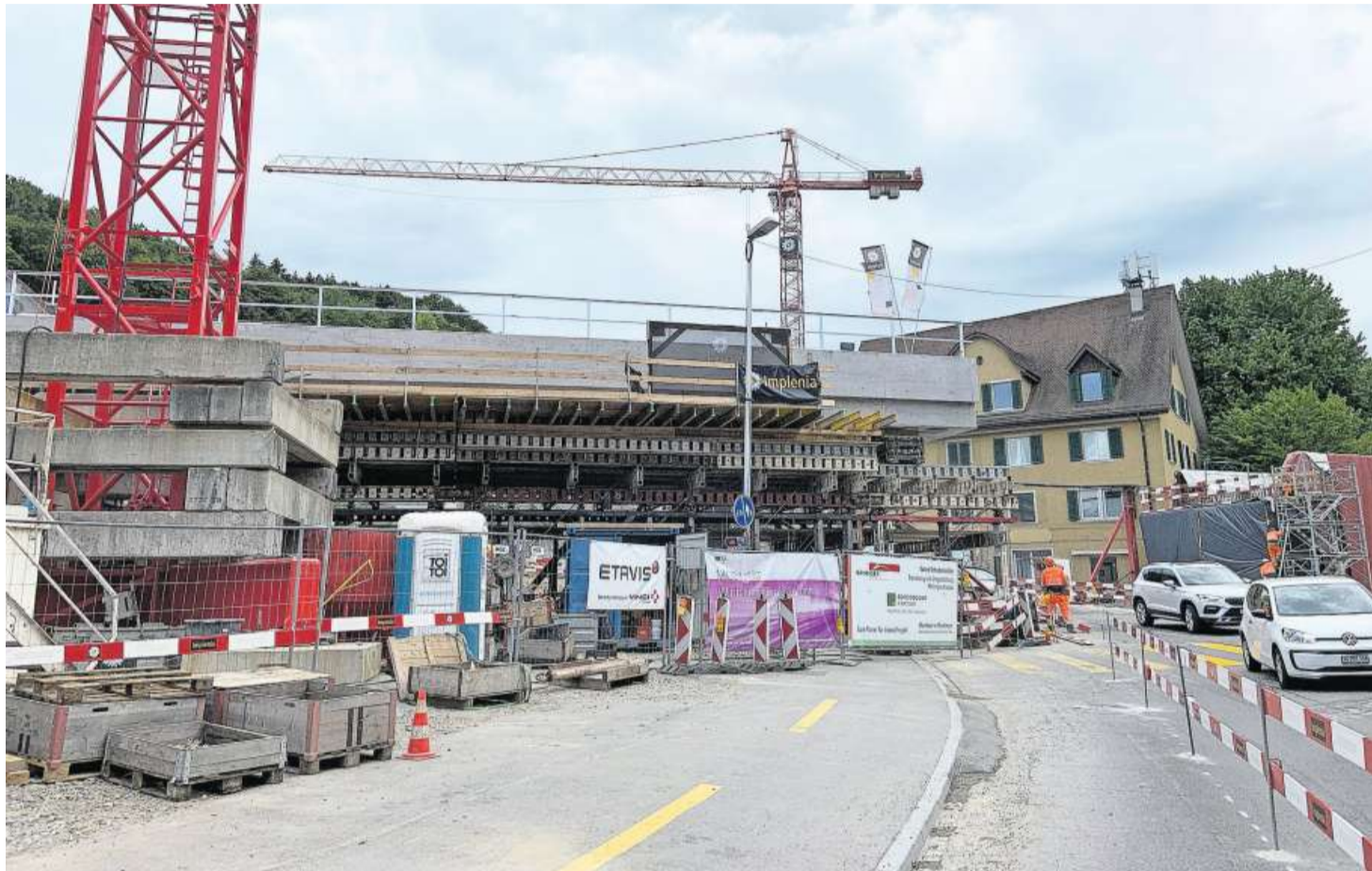
Ab Freitag wird die neue SBB-Brücke samt Gerüst auf sogenannten Carriern nach rechts über die Strasse zum Widerlager geschoben. Bild: afr
