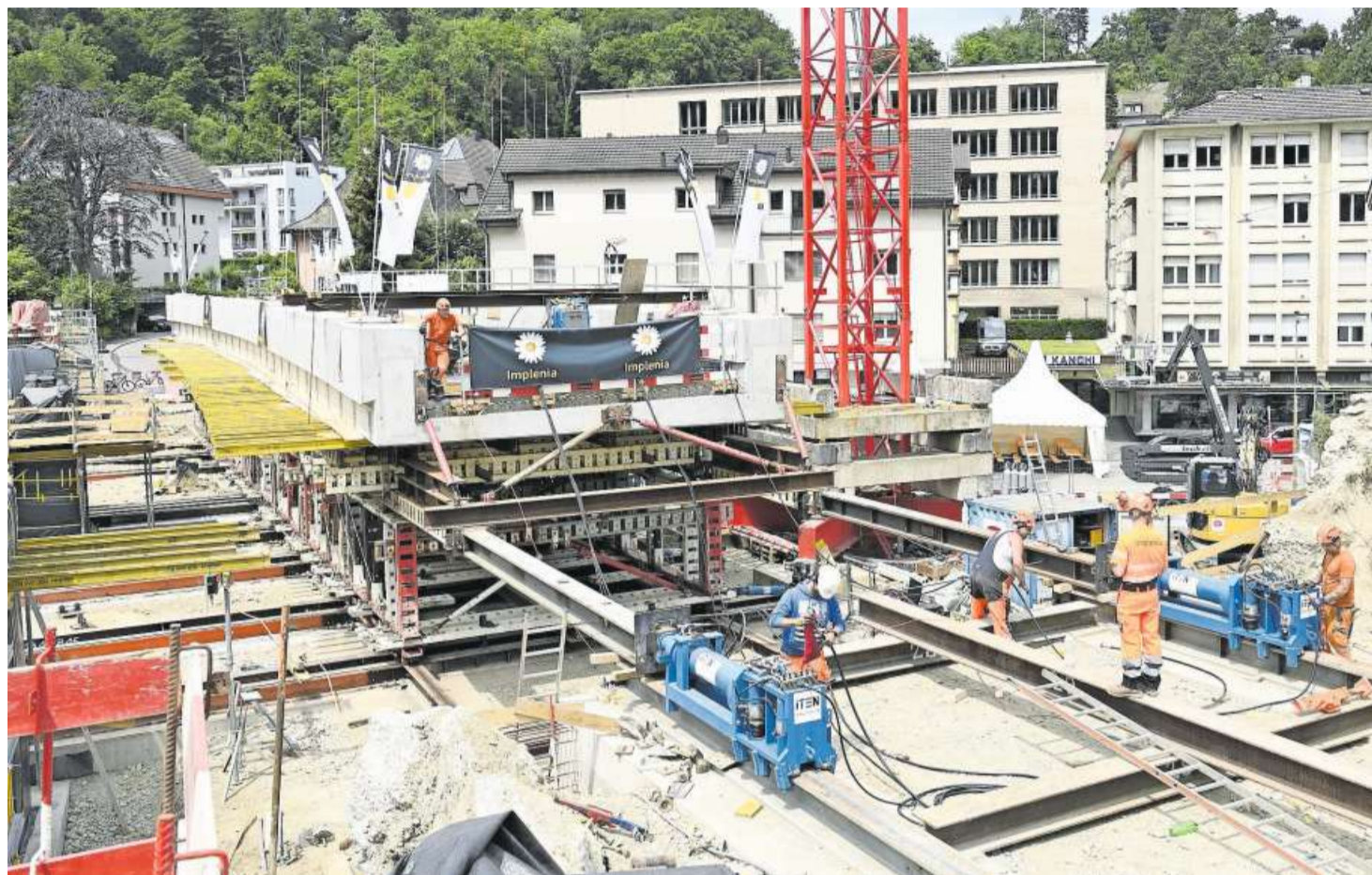
Die neue SBB-Brücke beim Schadenmühleplatz in Baden wird mithilfe von Hydraulik-Pressen verschoben.
