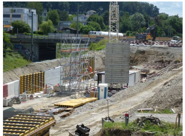
Stützmauer Einfahrt Hausen Südast
