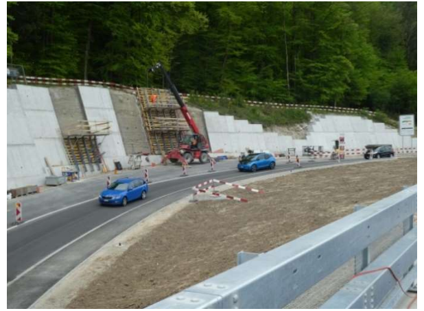
Stützmauer Aarauerstrasse Westast
