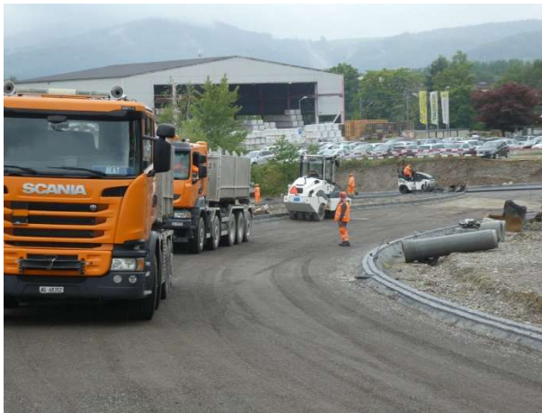
Belageinbau Verbindungsspanne
