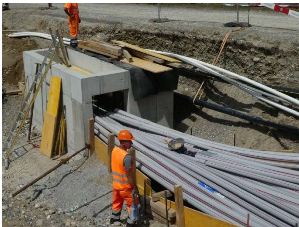
Umlegungen Werkleitungen Verbindungsspanne
