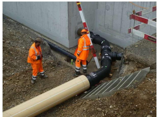
Umlegung Werkleitungen
