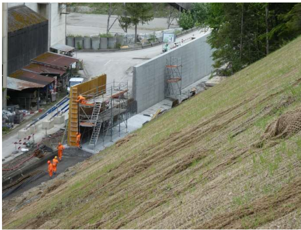
Stützmauer im Bau (S-08810) Westast
