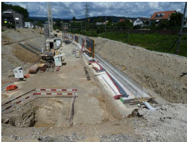
Aushub und Stützmauer Einfahrt Hausen
