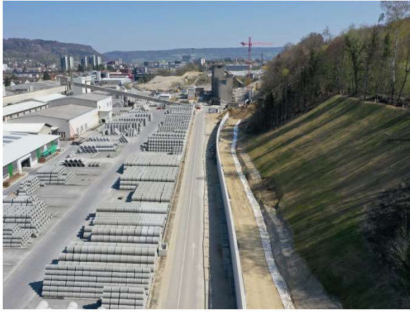
Grosse Stützmauer (S-88010) Westast
