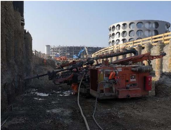
Bild 9: Bohren der Anker im Bereich Parkhaus
