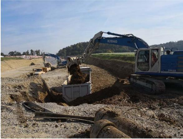
Bild 1: Aushub im geböschten Teil der Baugrube
