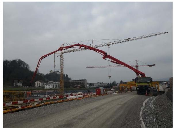
Bild 18: Einsatz Betonpumpe beim Betonieren der ersten Tunneldecke
