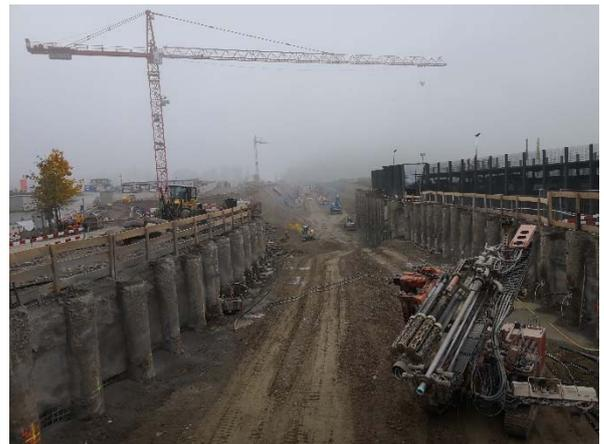
Bild 6: Baugrubensicherung mit ausgefachter Bohrpfählwand
