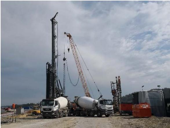
Bild 3: Erstellung der Bohrpfähle im Doppelkopfbohrverfahren
