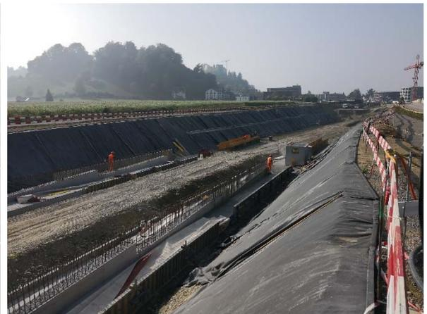
Bild 12: Start Betonarbeiten bei der Rampe Horner (Fundamente mit Kicker)
