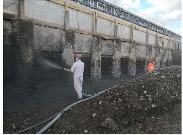
Bild 8: Ausfachung des Baugrubenabschlusses mit Spritzbeton
