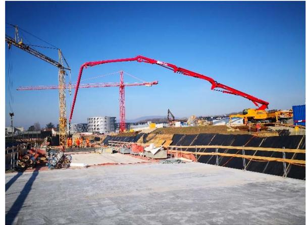
Bild 4: Betonieren der Tunneldecke mit einer Betonpumpe
