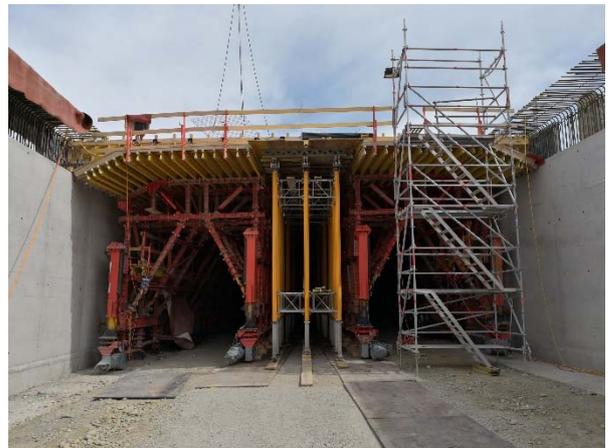
Bild 12: Verbreiterung des Schalwagens mit konventionellen Mittelstützen im Bereich der Aufweitung für die Nothaltebucht
