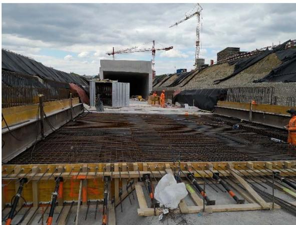
Bild 17: Bodenplatte in der Rampe Horner
