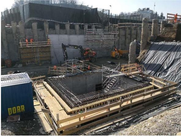
Bild 7: Stapelbecken für Tunnelentwässerung unterhalb der Betriebszentrale
