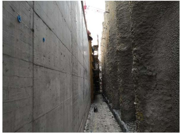
Bild 14: Betonarbeiten unter beengten Platzverhältnissen zwischen Tunnelwand und Baugrubenabschluss
