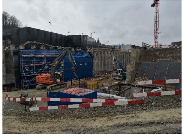
Bild 8: Tunnelabdichtung im Bereich der einhäuptigen Schalung
