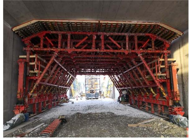
Bild 2: Schalwagen für die Tunneldecke
