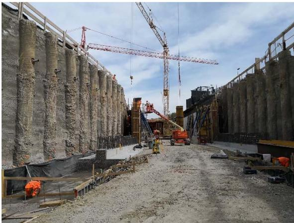
Bild 11: Arbeitsstellen Kicker (Fundament und Wandansatz) und Tunnelwand
