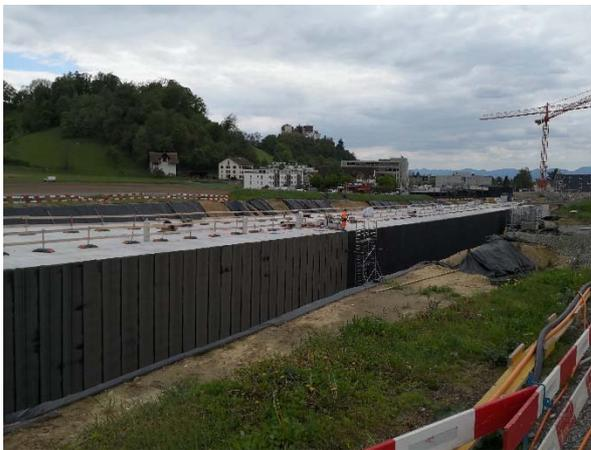
Bild 15: Tunnelabdichtung mit PBD-Bahnen
