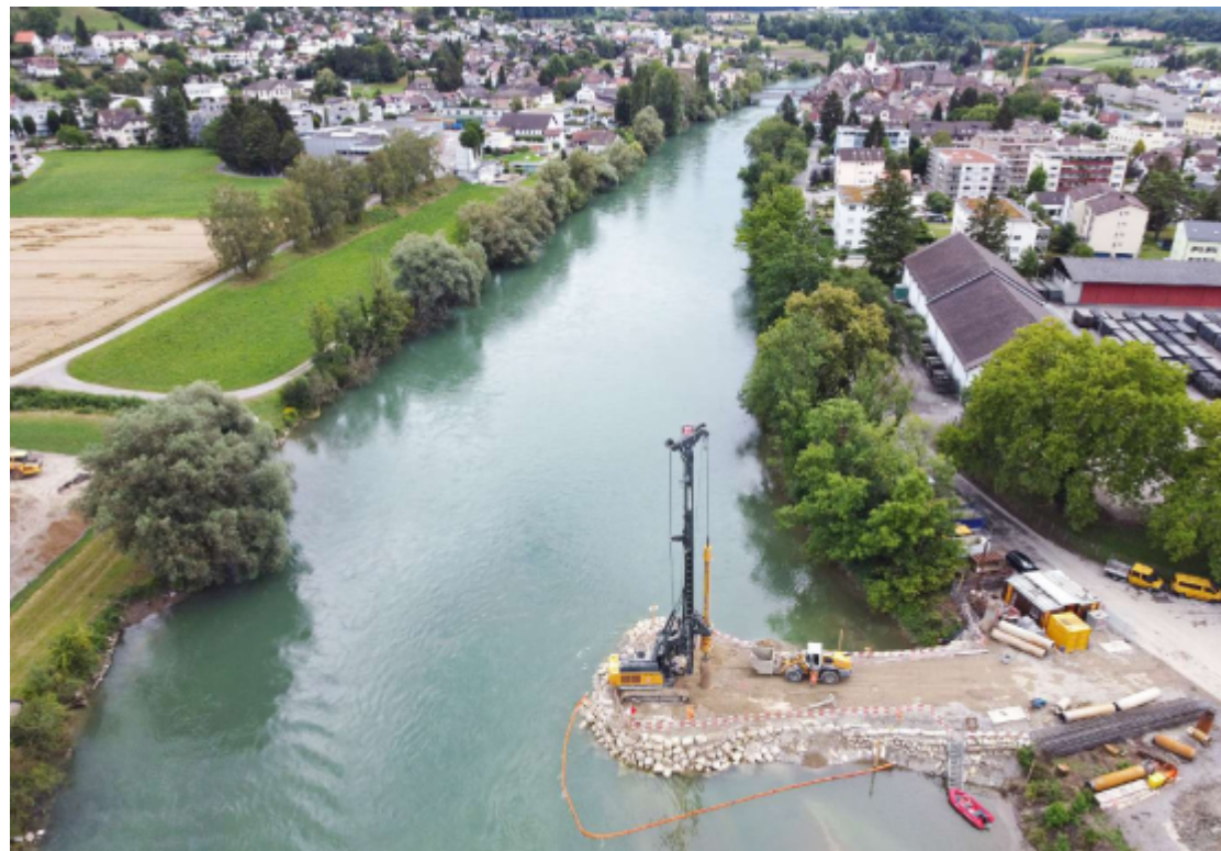
Der Blick von oben auf den Damm, der für die Betonierung der Brückenpfeiler (auf der Stadtseite) erstellt wurde. Fotos: Viktor Zimmermann
