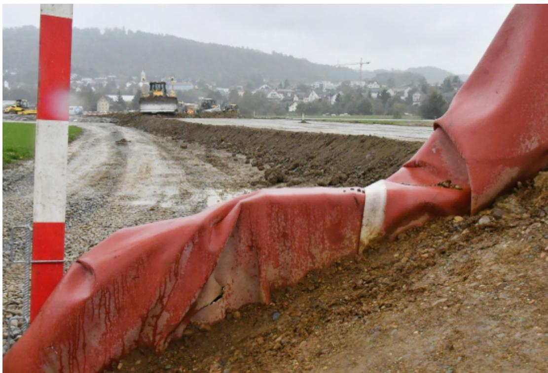
**Ein grosser Teil an sauberem Aushub wird für die Dämme auf der Baustelle Umfahrung weiter verwendet. Foto: hhs**
