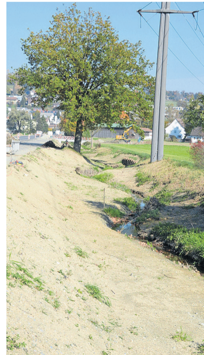
Der Bach schlängelt sich Richtung Bünz, das Wasser hat jetzt viel mehr Platz als zuvor. Und trotzdem konnte der alte markante Baum bei der Abzweigung Sorenbühlweg erhalten werden.
