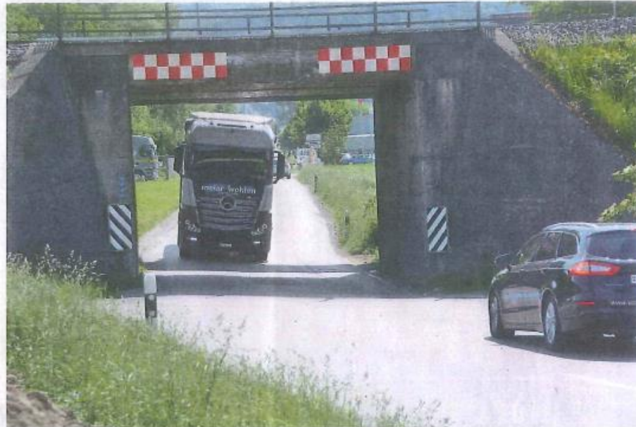
Mit dem Sanierungs- und Ausbauprojekt sollen auch die beiden bestehenden Nadelöhre beseitigt werden. Links die heutige Situation bei der Bünzbrücke, rechts die zu wenig hohe und zu wenig breite SBB-Unterführung.
