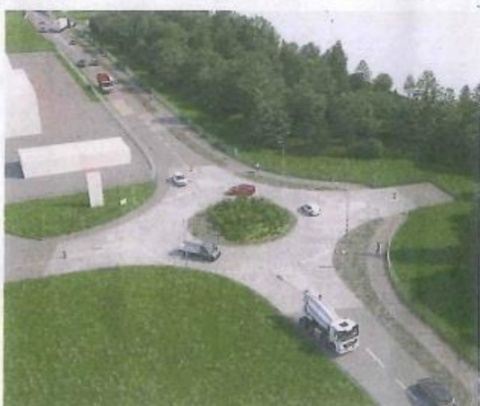
Ein Wunsch geht in Erfüllung: Dank des neuen Kreislaufs erhält die Ferro eine zweite Einfahrt ins Gelände (rechter Ast). Links geht es zur Cellpack und zum Coop Bau&Hobby-Markt.
