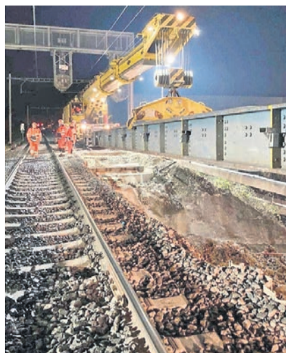
Nach dem Durchbruch kann die neue Hilfsbrücke montiert werden.
