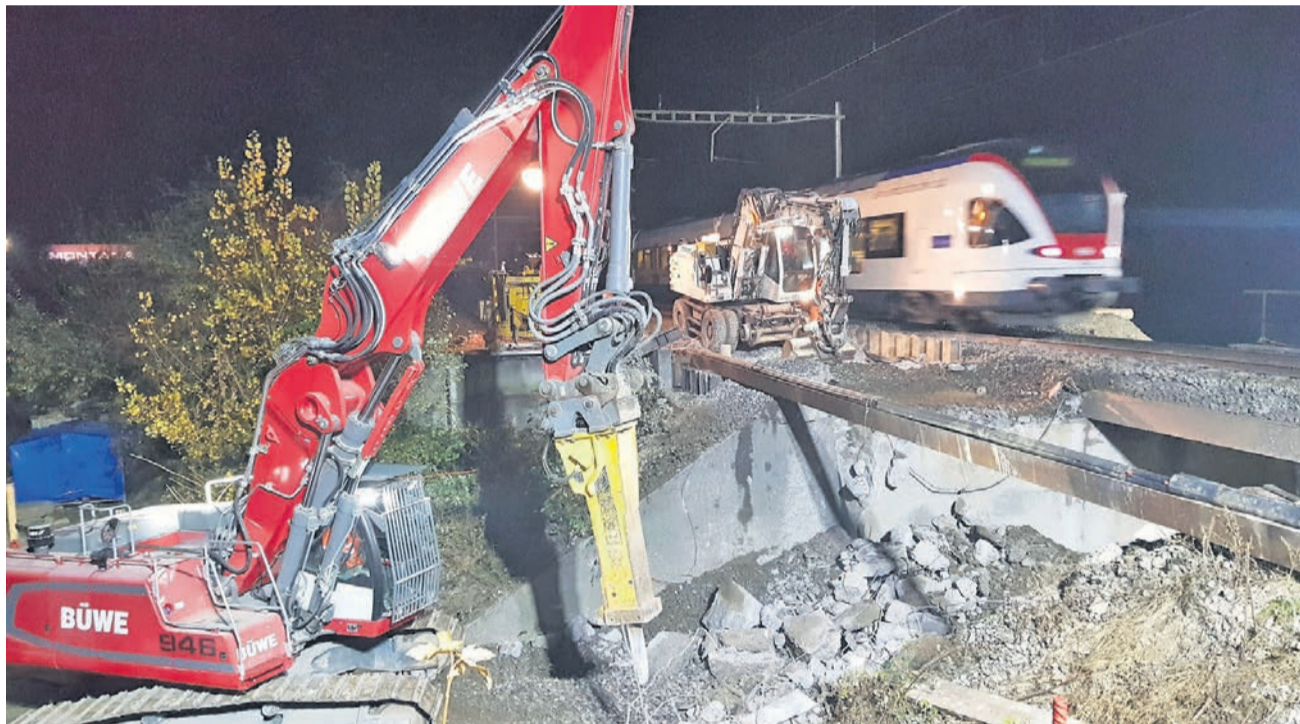
Mit schwerem Gerät geht es der alten Brücke an den Kragen. Immer wenn ein Zug passiert, muss eine Pause eingelegt werden.
