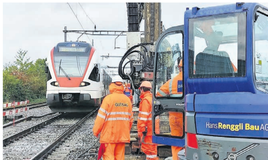
Nicht ungefährlich: Während auf der einen Seite das neue Gleis eingebaut wird, passieren auf der anderen Seite bereits wieder Züge.
