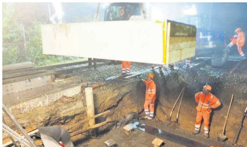
Die Fundamente für die beiden Hilfsbrücken wurden vorfabriziert und dann zur Baustelle transportiert, wo dann in der Nacht der Einbau erfolgte.
