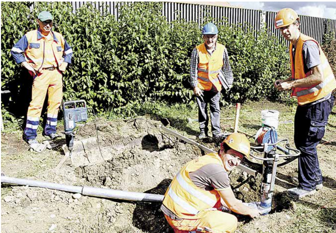
Interessiert verfolgen die Bauarbeiter, wie eine Spezialschraube im Boden verankert wird.
