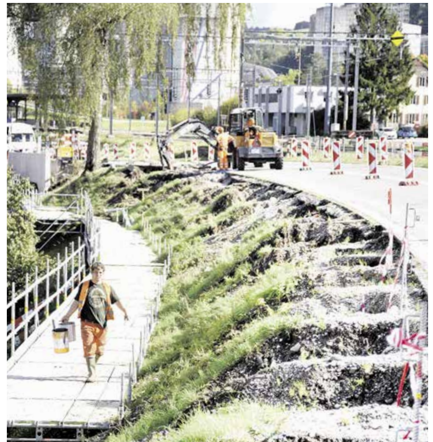
Die Bauarbeiten für die Lärmschutzwände schreiten zügig voran.
