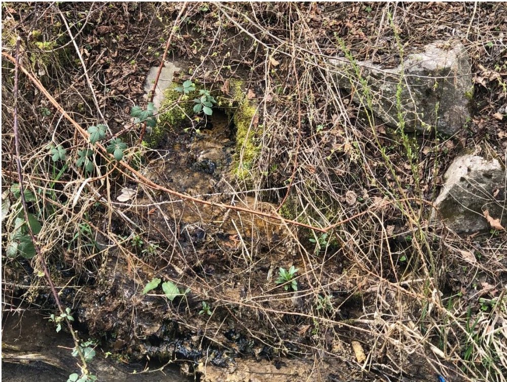
Drainageabfluss unterhalb Damm
