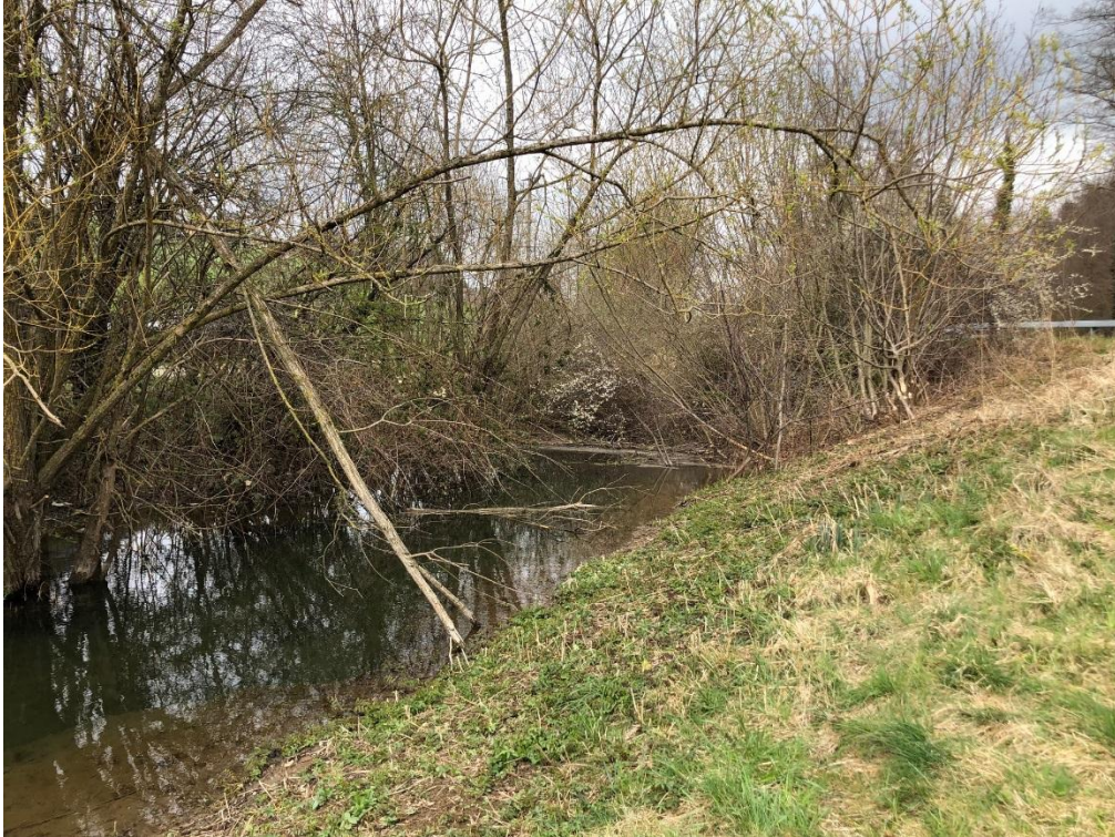
Blick auf Damm in Fließrichtung
