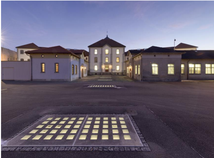
Blick vom Hof auf den Eingang des Flügels I
