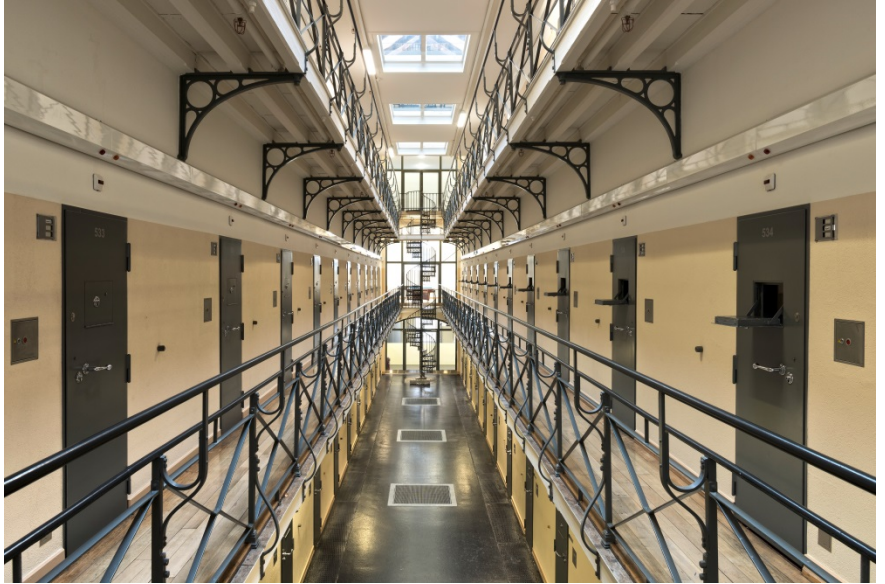
Flügel V – nach der Sanierung
