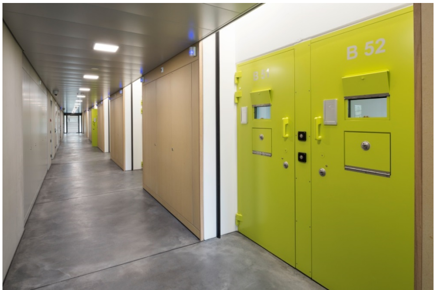
Korridor im Erweiterungsbau (Haus B) des Zentralgefängnisses
