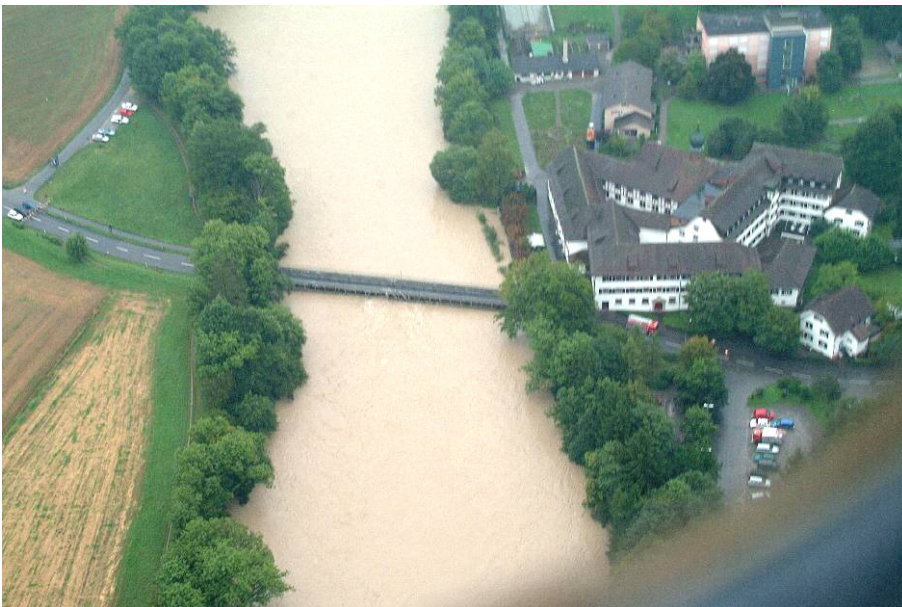
Abbildung 5: Hochwasser 2005 (Luftaufnahme von Westen)
