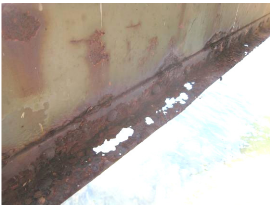
Abbildungen 2 und 3: Korrodierte Tragelemente
