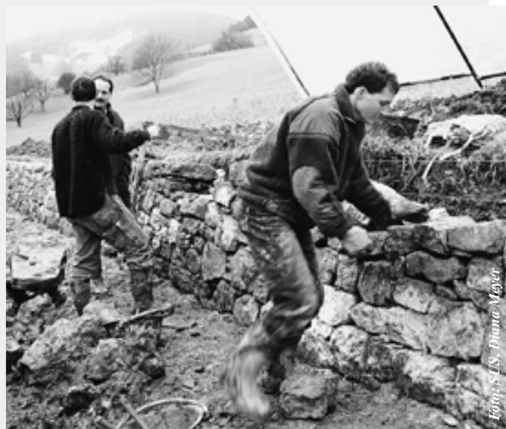
Bau einer Stützmauer in Küttigen
