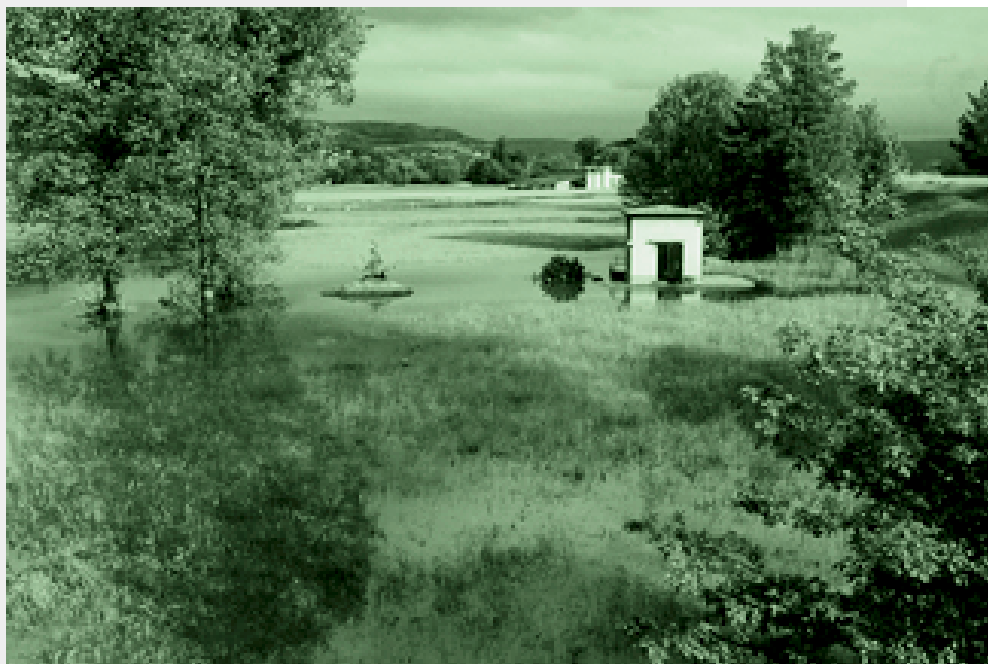
Überflutete Fassung bei Klingnau im unteren Aaretal während des Pfingst-Hochwassers 1999
