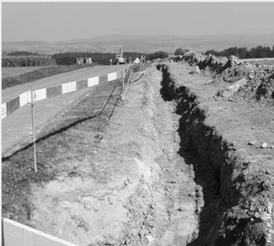
Grabarbeiten für Kanalisationsleitung
