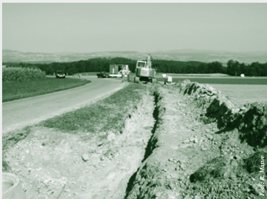
Grabarbeiten für Kanalisationsleitung
