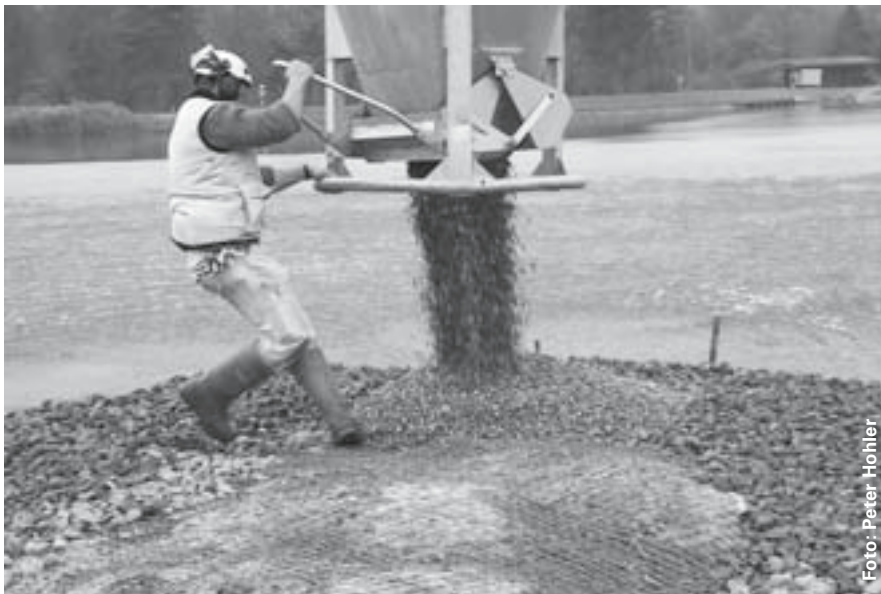
Die Kiesschüttung mitten im Klingnauer Stausee erfolgte per Helikopter. Rund 60 Mal musste der Kieskübel entleert werden.
