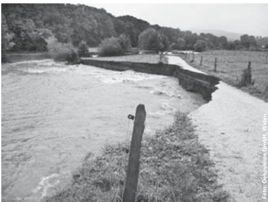
Ufererosionen während des Hochwassers vom 9. August 2007 verursachten in der Bünzaue Schäden an Kanalisation und Flurweg.
