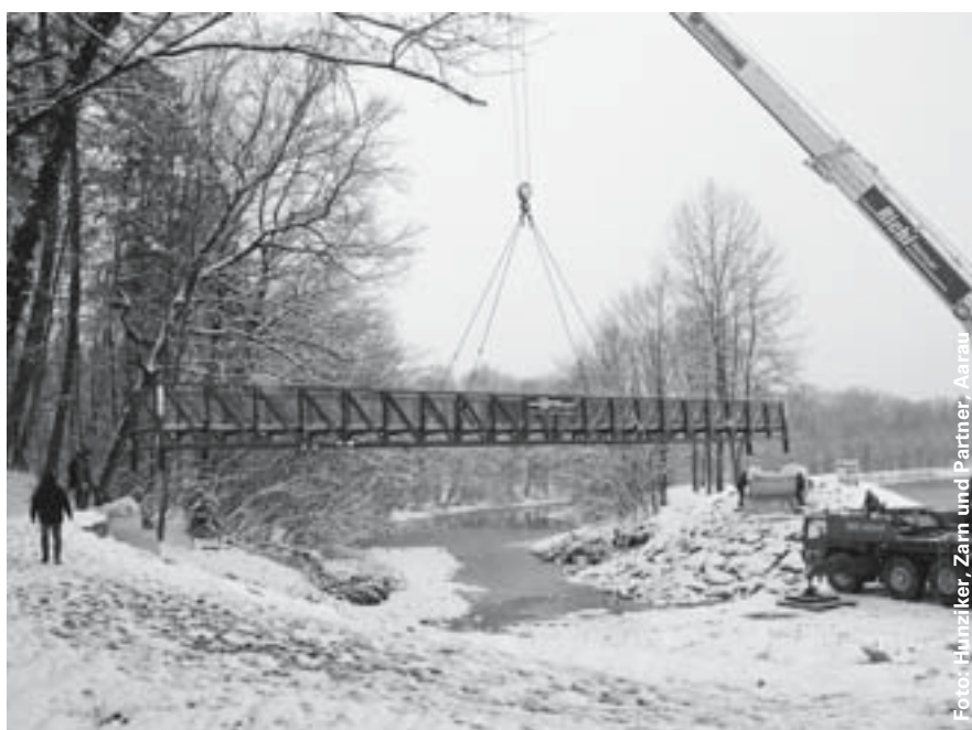
Eine neue Stahlbrücke verbindet das «Festland» mit der neu entstandenen Insel des Eggenwiler Sporens.
