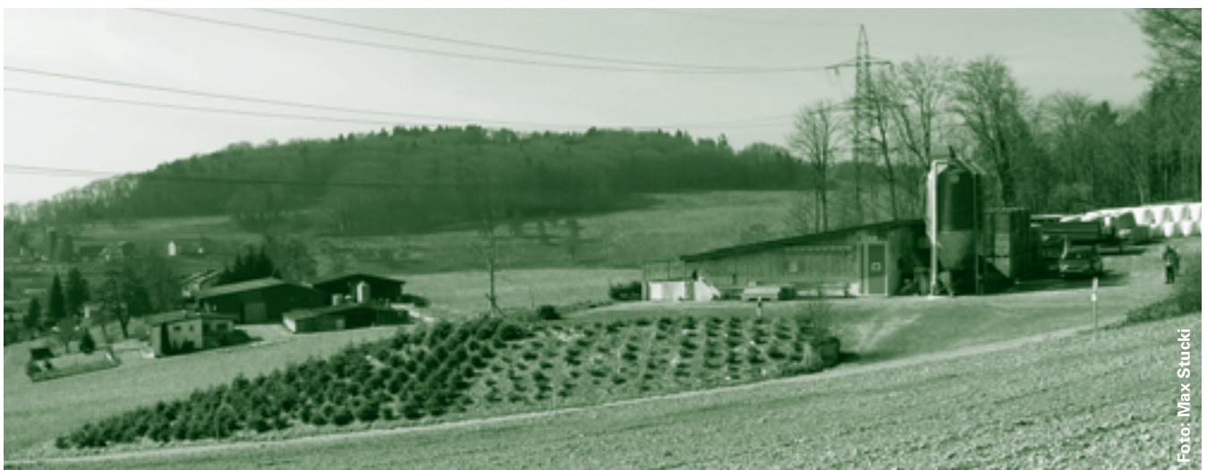
Dieser Mastschweinestall wurde rund 300 Meter von den bestehenden Betriebsgebäuden entfernt gebaut und hält dadurch den Mindestabstand zu den Wohngebieten ein.
