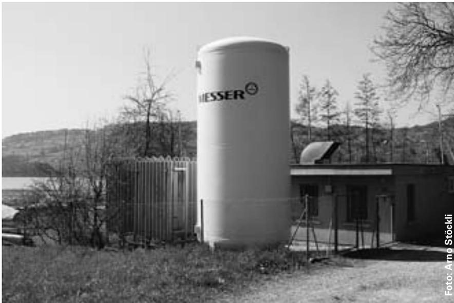
Im Seezopf bei Meisterschwanden befinden sich das Betriebsgebäude der Seebelüftung mit Kompressoren und Anlagen zur Bereitstellung von Sauerstoff.
