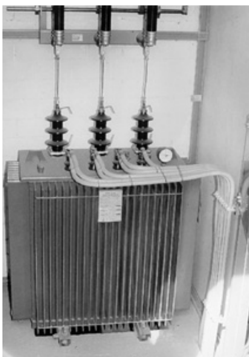
Kleinerer Transformator in einer Trafostation. Ohne analytische Prüfung gilt das darin befindliche Öl als PCB-verdächtig.
