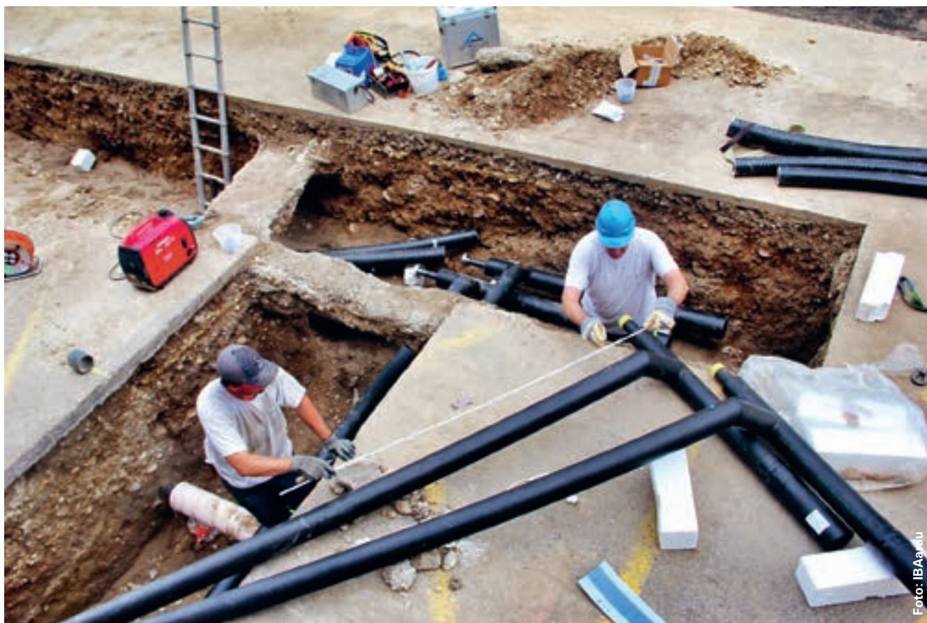
Arbeiter verlegen die Rohre für den Energieverbund Kasino. Bereits Anfang 2014 soll dieser Energieverbund die ersten Gebäude in der Innenstadt mit Wärme und Kälte aus Grundwasser versorgen.
