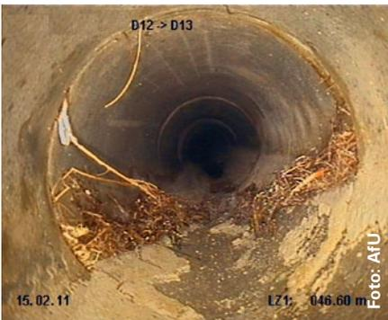
Durch Aufnahmen mit Kanalfernsehen sind Schäden wie dieser Wurzeleinwuchs klar zu erkennen.
