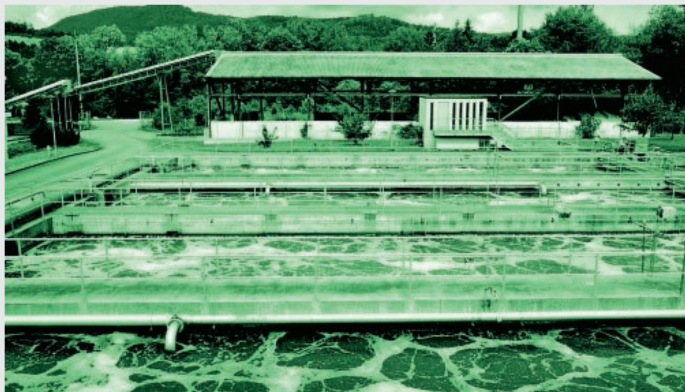
Blick über die Belebtschlammbecken zur Lagerhalle für entwässerten und gekalkten Schlamm in der ARA Lenzburg-Wildeggen.
