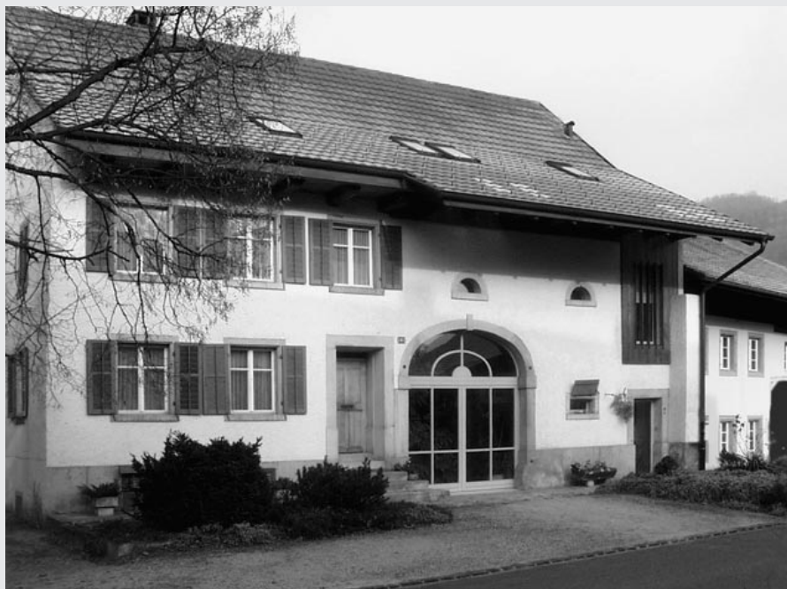
Hornussen: Sanfte Renovation und Einbau einer neuen Wohneinheit in die ehemalige Scheune
