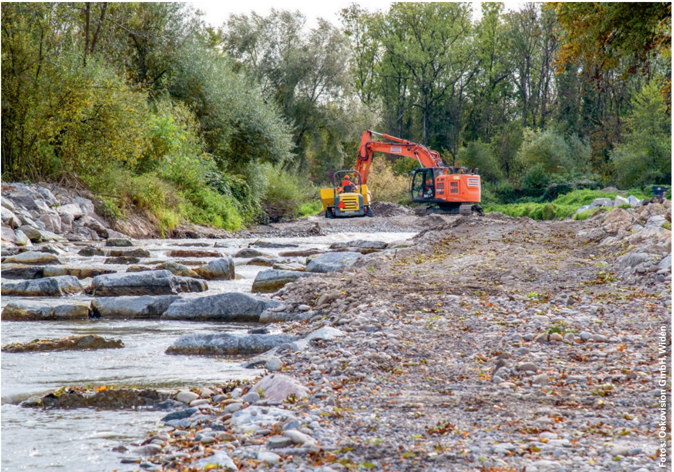
Die alte, aufgelöste Blockrampe wurde im Herbst 2021 in einen Raugerinne-Beckenpass umgebaut, der jetzt von allen Fischarten und auch von jungen sowie schlecht schwimmenden Fischen passiert werden kann.
