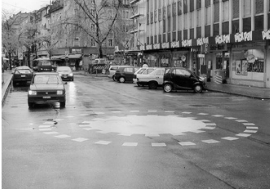
Die markierte Rondelle wirkt als optische Bremse.
