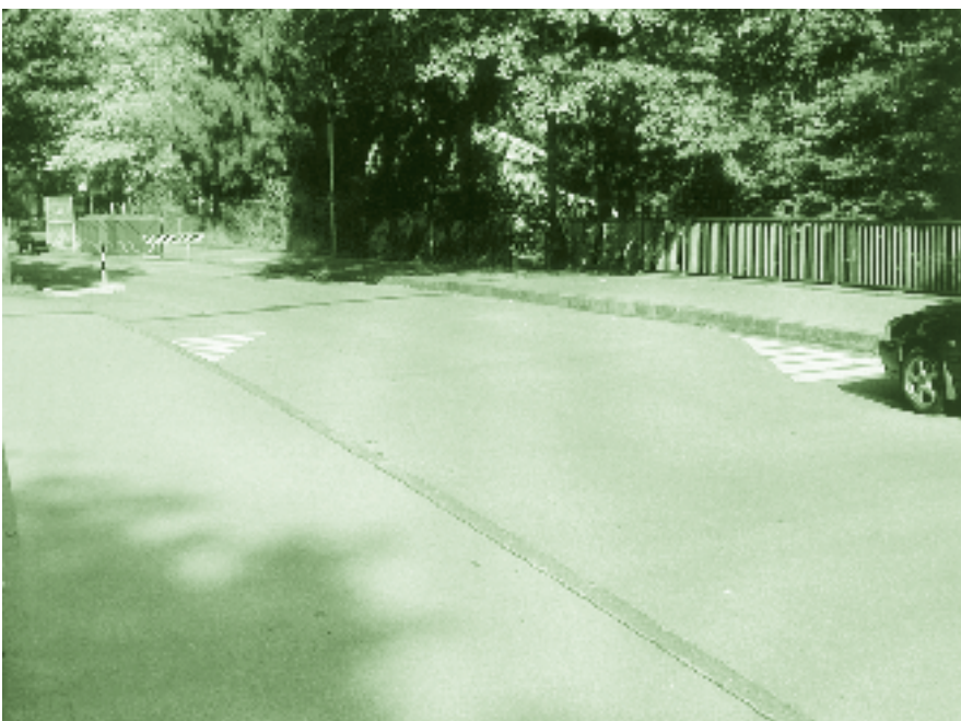
Eine weitere optische Verkehrsberuhigungsmassnahme: Parkfeldabschlüsse.
