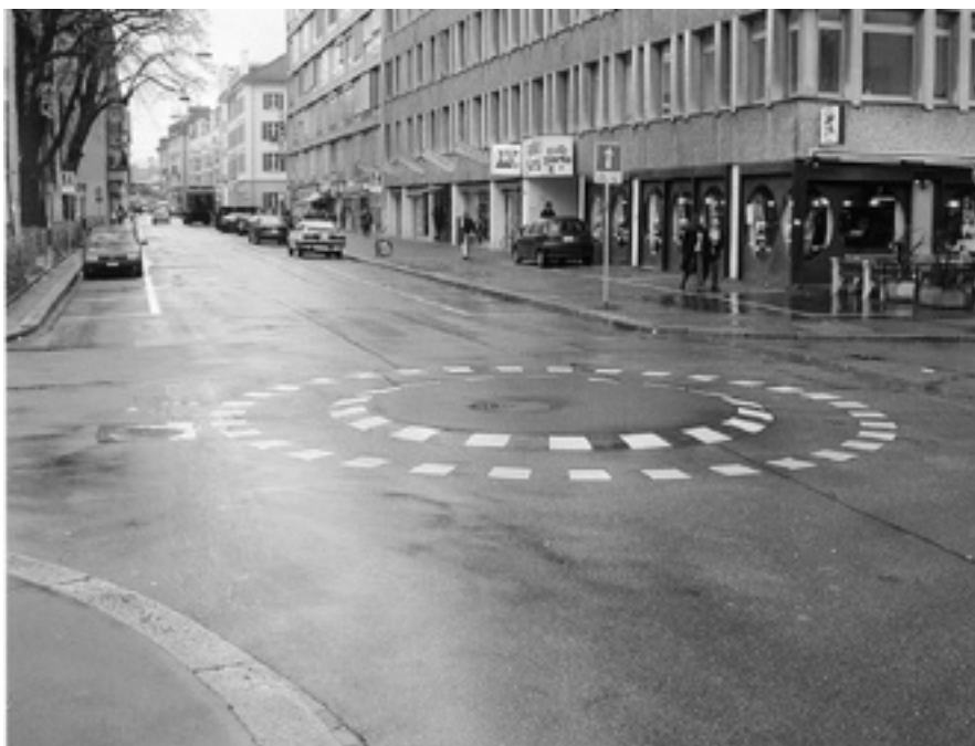
Markierte Rondellen sind optische Bremsen. Sie werden nicht um-, sondern überfahren und gelten darum nicht als Kreisel.
