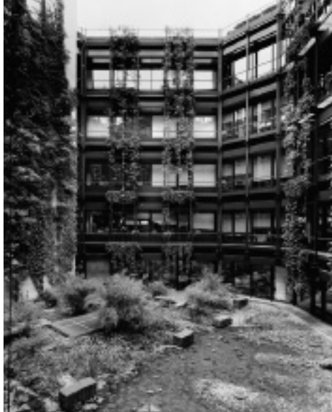
Fassadenbegrünung beim Credit-Suisse-Zentrum Uetlihof in Zürich
