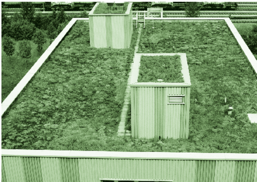
Dachbegrünung bei der Ciba Spezialitätenchemie in Kaisten
