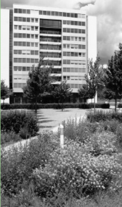
Magerwiesen und Ruderalflächen auf dem Firmengelände von Hoffmann-La Roche in Kaiseraugst
