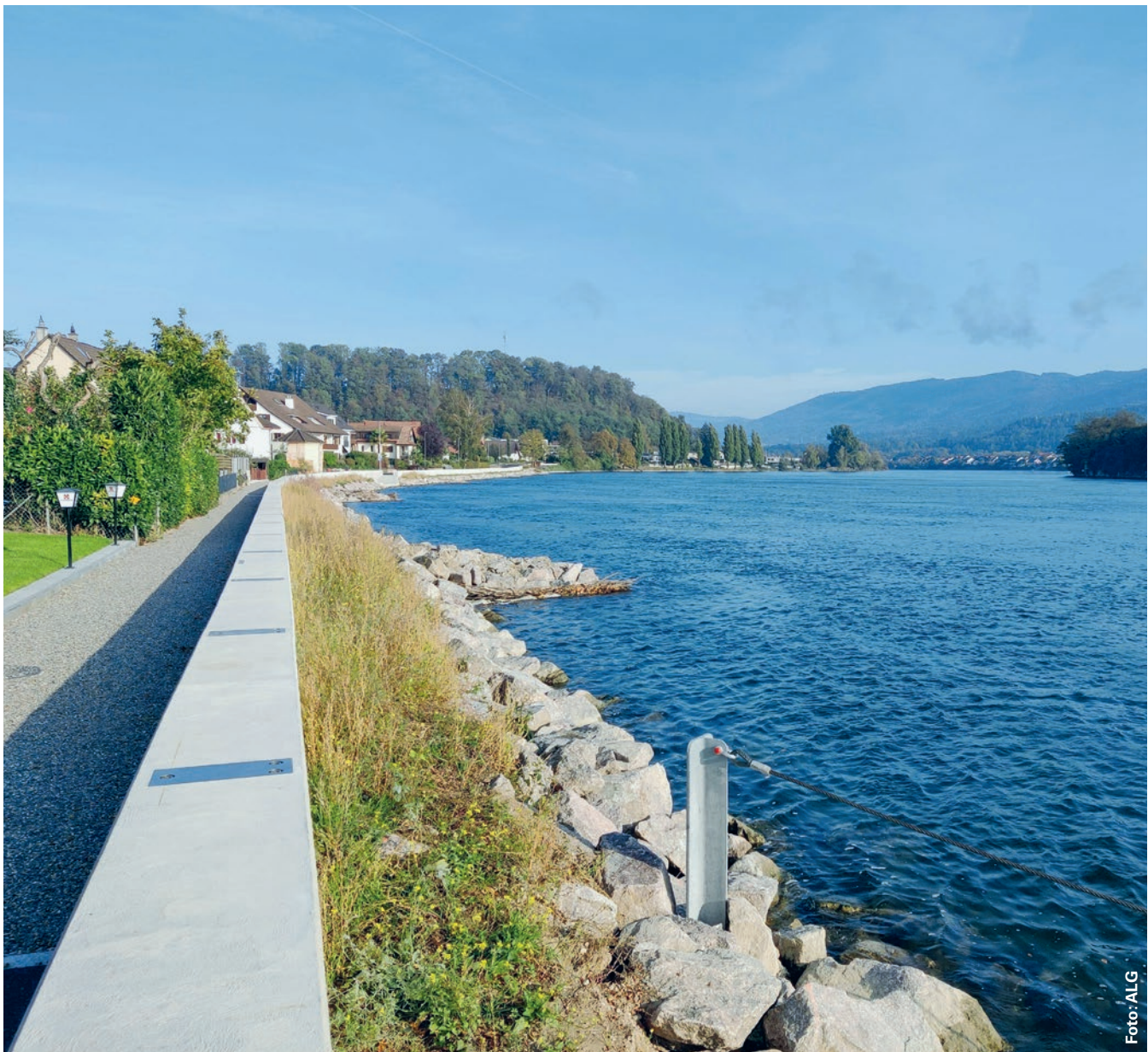
Ufermauer mit vorgelagertem Blocksatz und Dreiecksbuhnen. Auf der Mauer sind die Ankerplatten für das Dammbalkensystem ersichtlich.
