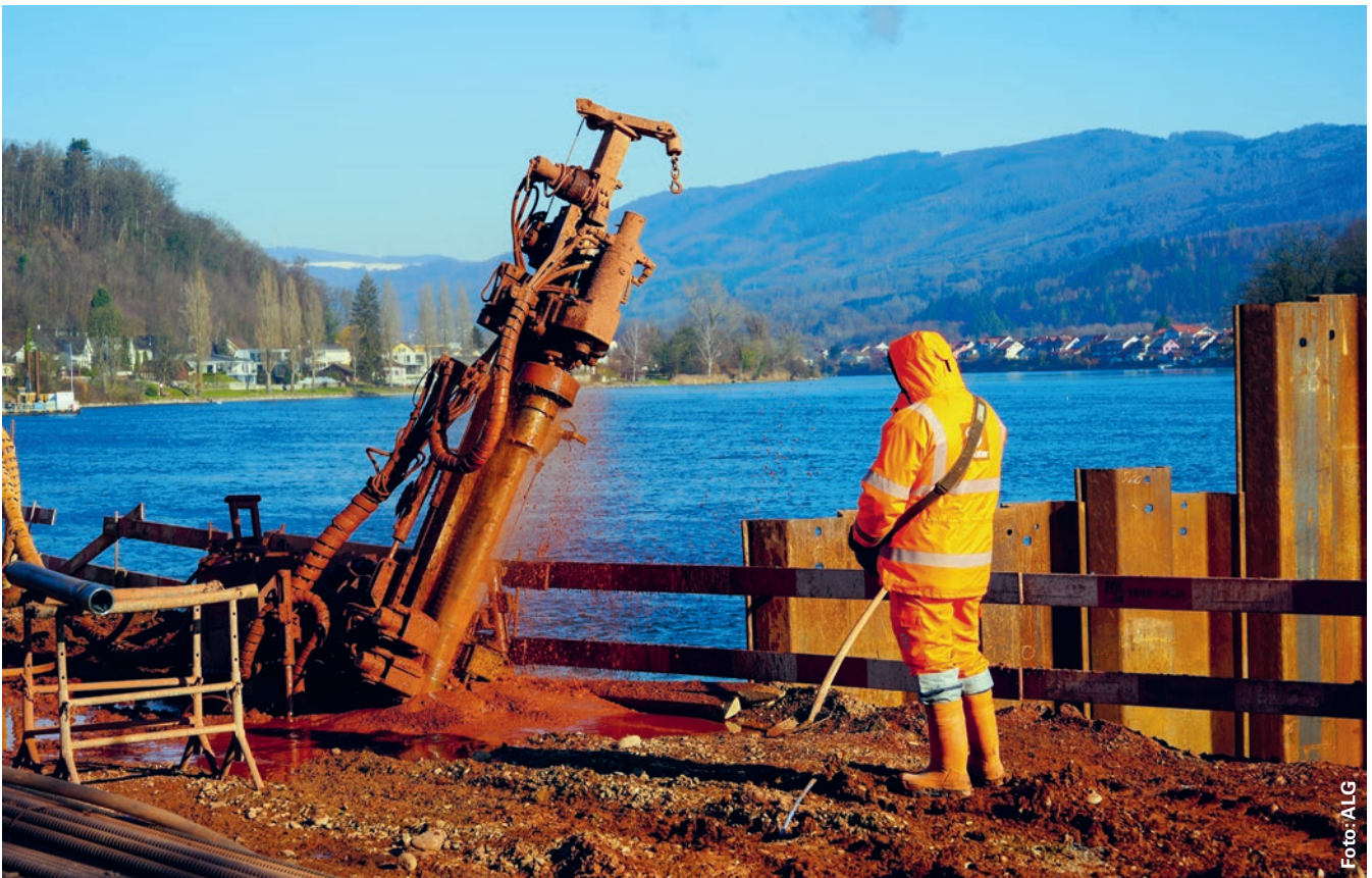
Beim Bohren der durchschnittlich zwölf Meter langen Mikropfähle kommt der rote Buntsandstein zum Vorschein.
