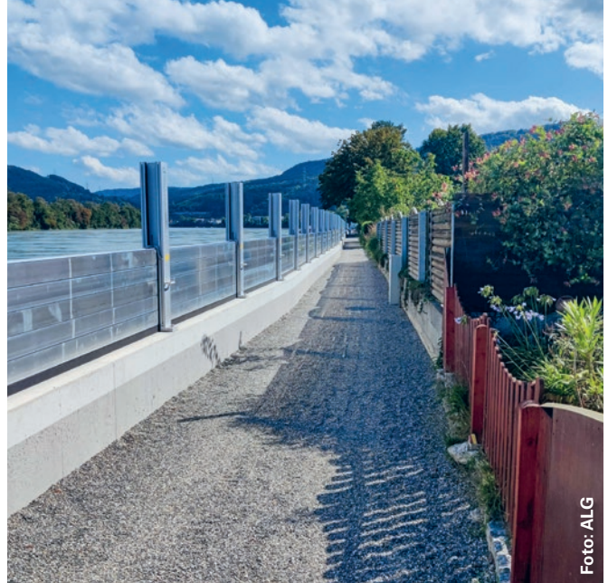
Hochwasserschutz damals und heute: links das Beaver-Schutzsystem beim Hochwasser im Juni 2013, rechts die neue Hochwasserschutzmauer mit bis auf halbe Höhe eingebauten Dammbalken beim Probeaufbau vom 1. September 2023
