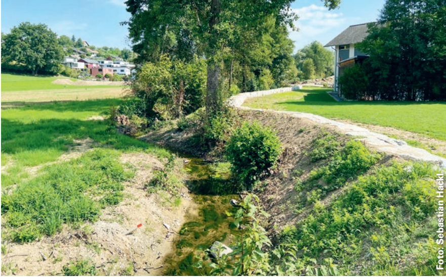
Der Uferdamm besteht gegen das Siedlungsgebiet aus Blocksteinen und gewässerseitig aus einer Böschung mit bindigem Bodenmaterial.
