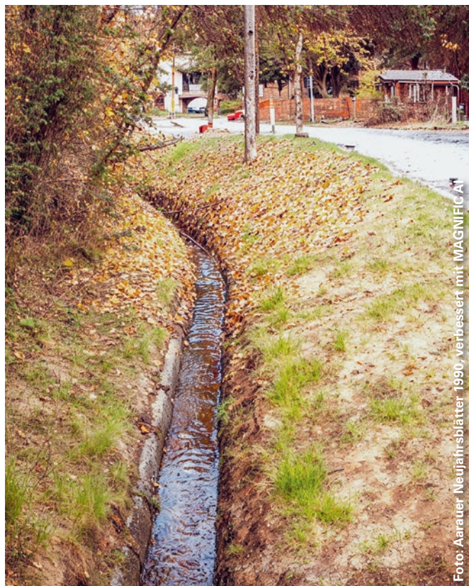
Lange Zeit fristete das Rombachbächli ein trostloses Dasein in einem Betonkanal – 1995 begann eine erste Phase der Revitalisierung.
