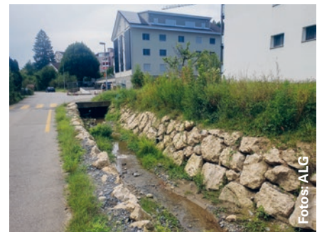
Das vorher schmale Gerinne wurde unterhalb der Brücke Rombachstrasse abgesenkt und mit Steinmauern geschützt und bietet nun viel Platz für die kommenden Hochwasser (links 2011, rechts 2024).
