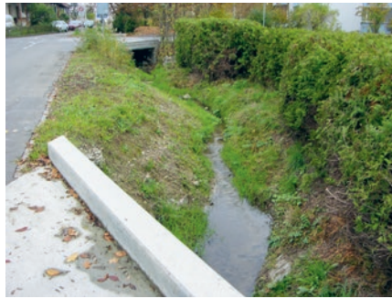
Zwischen der Brücke Giessenweg und der Brücke der Gysulastrasse wurde das Gerinne abgesenkt und verbreitert. Die vorher monotone Thujahecke wurde durch einheimische Sträucher ersetzt (links 2004, rechts 2024).
