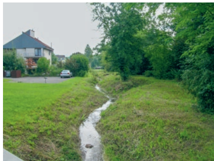
Entlang der Reihenhäuser an der Gysulastrasse wurde ein Damm erstellt und das Gerinne abgesenkt und verbreitert (links 2005, rechts 2024).
