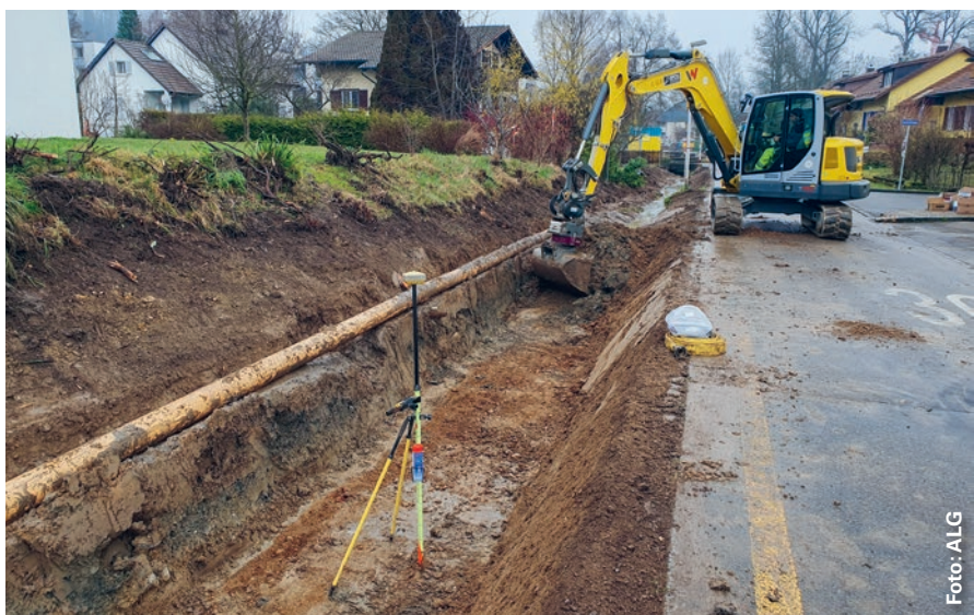
Entlang der Gysulastrasse hat das Rombachbächli nur ein sehr geringes Gefälle. Hier wurde 2024 die Gewässersohle abgesenkt. Zukünftig muss diese Strecke regelmässig von abgelagertem Feinmaterial befreit werden.
