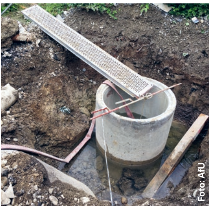
Über einen Pumpenschacht wird das Baustellenabwasser gefasst und in die Abwasservorbehandlungsanlage mit Absetzbecken und Neutralisation geleitet.
