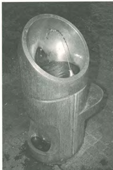
Brunnen für die Notwasserversorgung in der Stadt Zürich. Die rund 100 formschönen Trinkbrunnen sind an das besondere Quellwasser- netz angeschlossen, welches auch Spitäler und Zivilschutzbauten beliefert. (Foto: Stefan Binder, Abteilung Umweltschutz)
