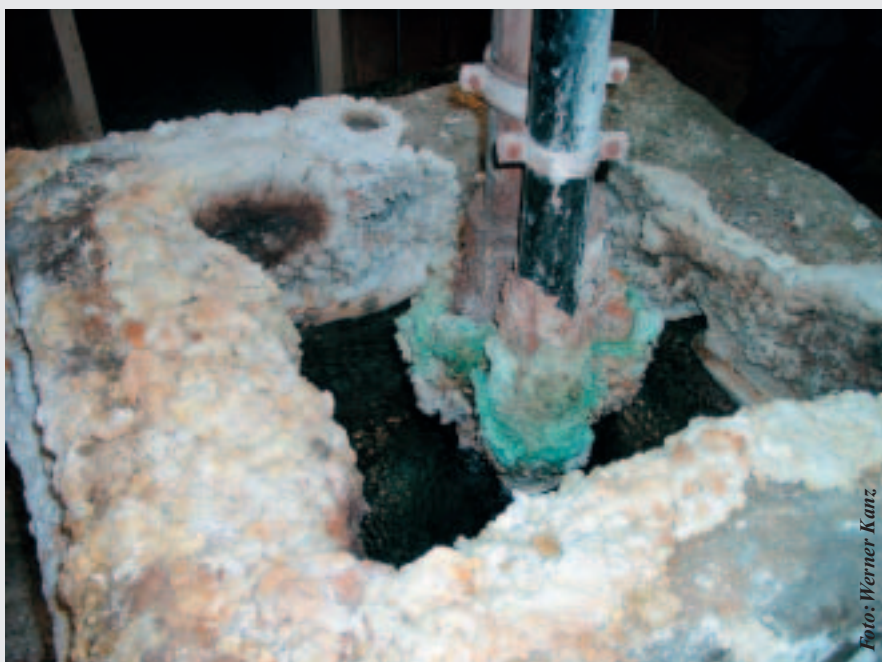
Mineralausblühungen an der Schwanen-Fassung
