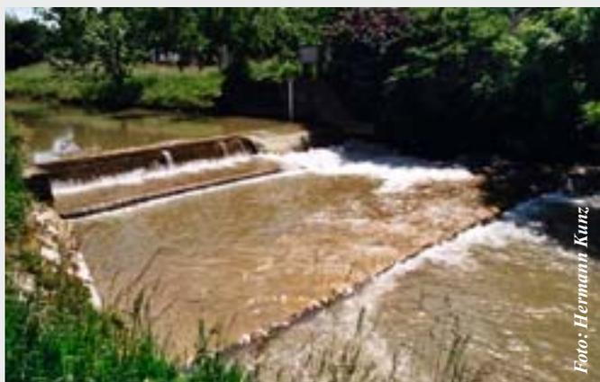
Die Messstation an der Sissle bei Eiken vor dem Umbau: Eine zwei Meter hohe Schwelle verhindert die Fischgängigkeit.
