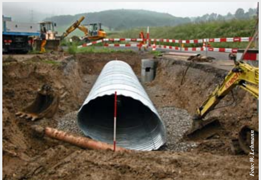
Der Wellstahldurchlass für die Querung der Kantonsstrasse
