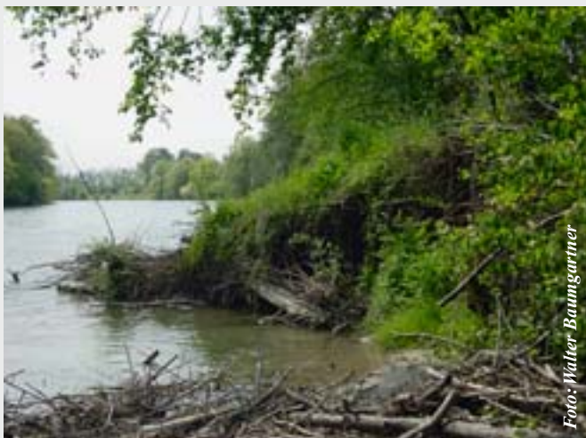
Dank dem Einbau von Aushubmaterial wurden die Buhnen rasch begrünt.
