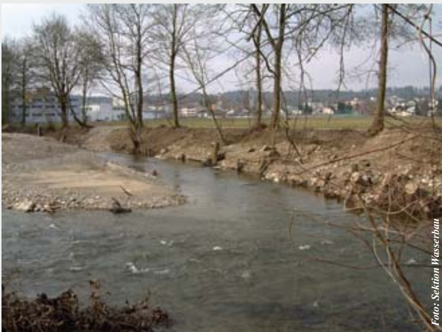
Im Zuge der Renaturierung wurde der Beton entfernt. Die Steine aus der Pflasterung wurden als Gestaltungselemente in der Sohle wieder verwendet. Auch die angefallenen Baumstrünke wurden an die Wasserlinie verlegt und dienen noch einige Jahre den unterschiedlichen Wasserlebewesen als Deckung.
